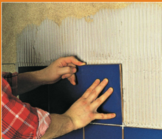
Układanie okładziny ceramicznej metodą płytki na płytki.
