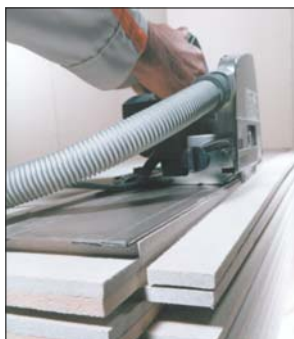
Z płyt układanych w narożniku pomieszczenia i wzdłuż ścian należy usunąć zakładki
