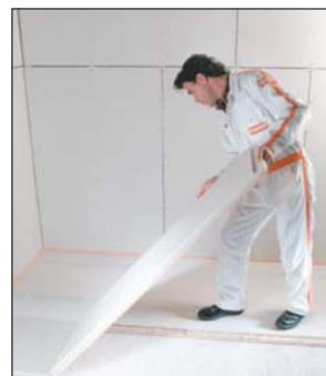
Kolejne warstwy układane są w systemie ciągłym, od lewej strony do prawej a poszczególne elementy sklejane są na zakładkach klejem, nanoszonym dwoma pasmami
