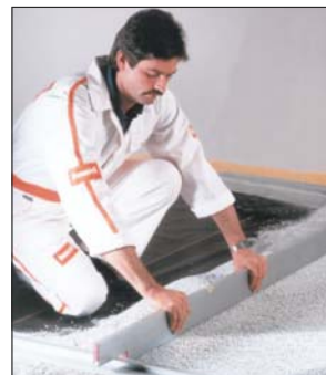
Niwelacja podsypki poziomującej za pomocą zestawu łat: prowadzących i ściągającej
