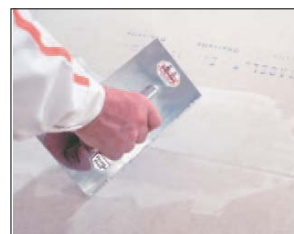
Po wyschnięciu i usunięciu nadmiaru kleju, spoiny i główki wkrętów należy zamaskować masą szpachlową Fermacell
