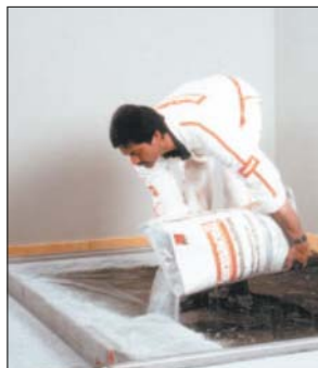
Układanie podsypki poziomującej
