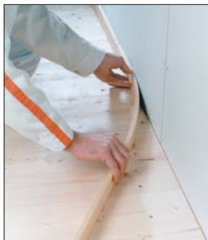
Układanie taśmy dylatacyjnej wzdłuż ścian
