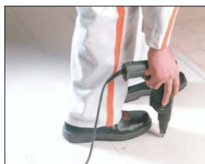
Właściwy docisk sklejaných płaszczyzn zapewniają systemowe wkręty 3,9x19 mm w rozstawie co 15 cm
