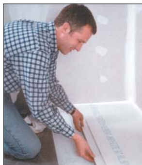
Układanie płyt rozpoczynamy od lewej strony pomieszczenia, wzdłuż ściany, dociskając płyty do taśmy dylatacyjnej
