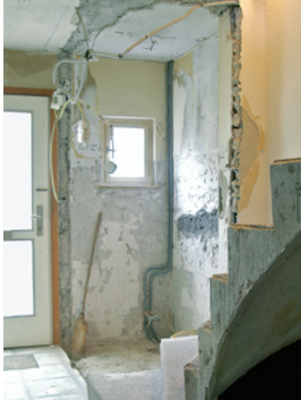
1. Pierwsza czynność: wyburzenie ścianek małej komórki przy wejściu oraz bocznej ścianki w korytarzu przy schodach,...
