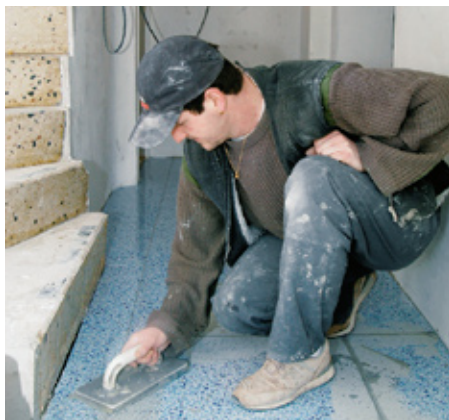
7. Szklane płyty podłogowe fuguje się w taki sam sposób jak ceramikę. Najbardziej praktyczna jest tutaj szara fuga cementowa.
