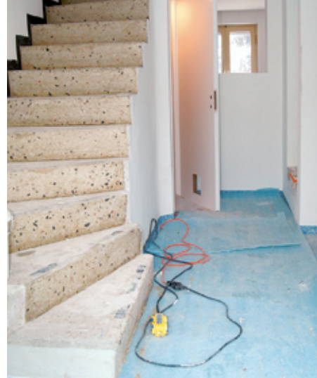
9. Pierwsza część pracy wykonana: nowa podłoga, otynkowane na biało ściany, nowe drzwi piwniczne oraz schody czekające na nową wykładzinę.
