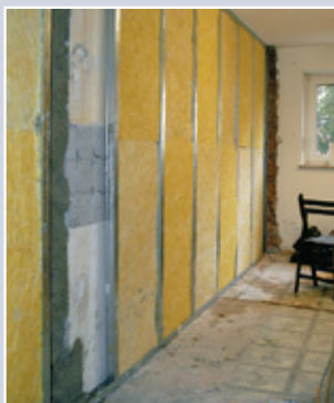
Konstrukcja metalowa jest położona w ten sposób, by nie przenosić drgań i dźwięków. Przestrzeń wypełniono materiałem izolacyjnym.
