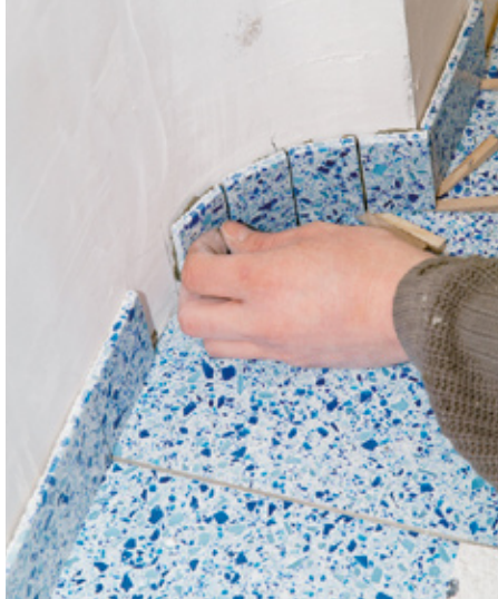
8. Cokołowe płytki z tego samego materiału tworzą efektowne wykończenie krawędzi bocznych. Zaokrąglenia wykańcza się małymi płytkami.
