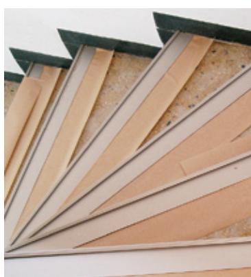
17. ...zresztą jak na stopniach. Tutaj przykleja się taśmę pod profilem i przed następnym stopniem.
