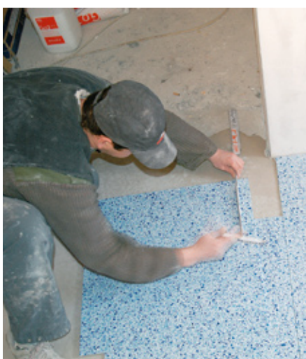
5. Pomiędzy płytkami pozostawiono jedynie drobne szczeliny, aby nie psuły one efektu błyszczącej tafli. Już po trzech godzinach można po nich chodzić.
