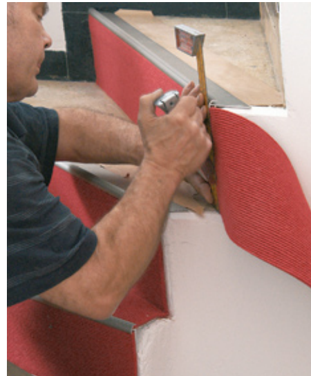
15. Wystające od strony zewnętrznej schodów kawałki wykładziny przycinano wzdłuż linii. Ostry nóż jest tutaj niezbędny narzędziem.
