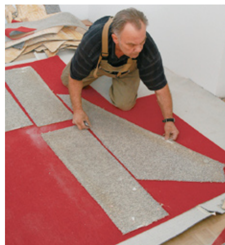
12. Nowa wykładzina na schodach też musiała być dokładnie przycięta, dlatego wykorzystano stare elementy jako szablonu do wytyczenia nowych.
