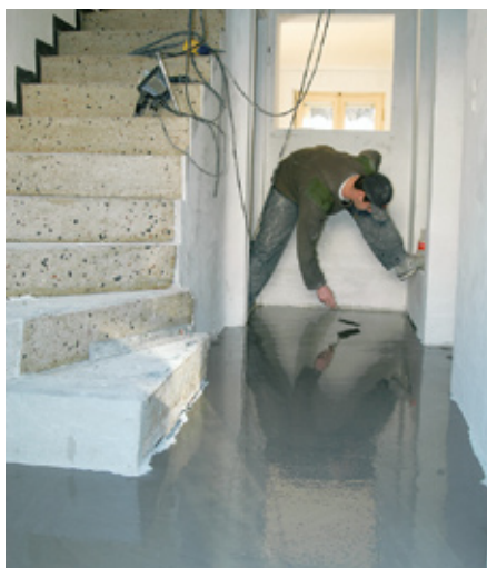
3. ...pozostawiając jedynie wycięcie na zamontowanie okna. Zaraz potem przystąpiono do wyrównania podłoża. Płynną zaprawą zniwelowano nierówności.
