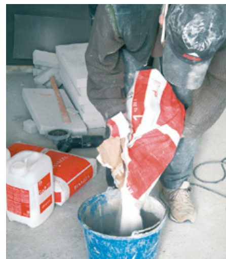
4. Na okładzinę wybrano wielkoformatowe płytki zrobione z granulatu szkła z dodatkiem żywicy epoksydowej, które wymagają specjalnego kleju.
