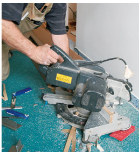
11. Ponieważ schody są kręte w dolnej i górnej części, trzeba było starannie przyciąć metalowe profile, aby końcówki idealnie pasowały.
