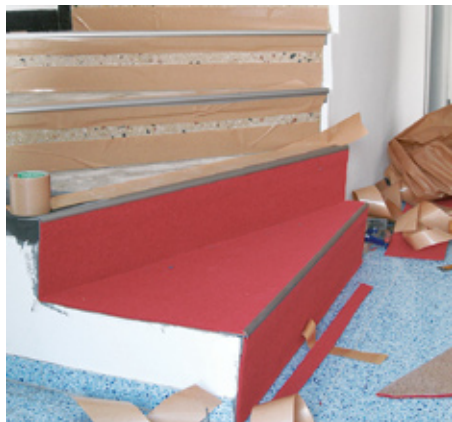
13. Potem można było przystąpić do przyklejania gotowych fragmentów, zarówno na powierzchni poziomej, jak i na czołowej, przy czym...
