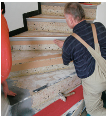
10. Jako ochrona krawędzi, ale także w celu zaakcentowania nowoczesnego wystroju założono aluminiowe profile brzegowe.
