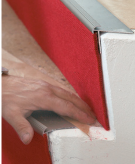
14. ...najpierw przykleja się pas wykładziny na powierzchni czołowej, wsuwając ją przedtem pod aluminiowy profil brzegowy i mocno dociskając.
