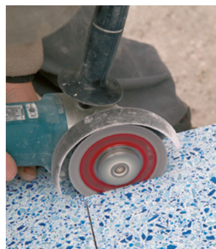
6. Ewentualne przycięcia robi się przy pomocy tarczy diamentowej. Równe podłoże i dobrej jakości klej są podstawą idealnego przylegania płyt.
