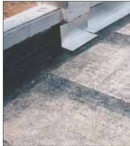
9. Potem uszczelnia się całą powierzchnię tarasu pierwszą warstwą papy bitumicznej i można przystąpić do obróbki ...
