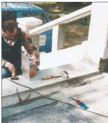
18. Na miejscu wykonano blaszane kształtowniki, którymi obramowano przyłącze schodów. Ponieważ po stronie zewnętrznej słupka ...
