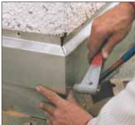
26. ... i zagięciu blachy w narożach wykonano ładne, szczelne połączenie, które następnie zostało zanitowane.
