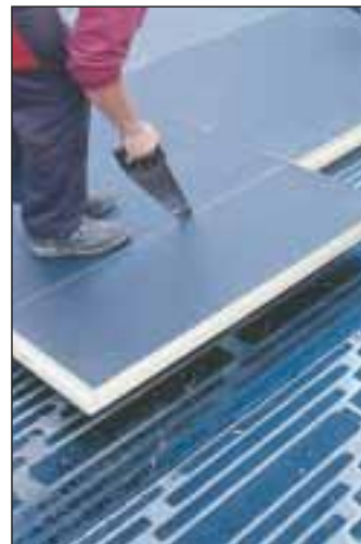
6. Płyty wykonane z utwardzonej pianki i pokryte warstwą aluminiową można przycinać ręcznie.
