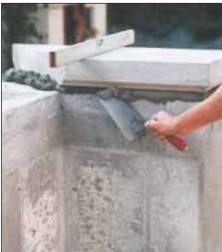
13. Po nałożeniu płyty na zaprawę, wyrównaniu i obstukaniu gumowym młotkiem, zbiera się kielnią nadmierną ilość zaprawy.
