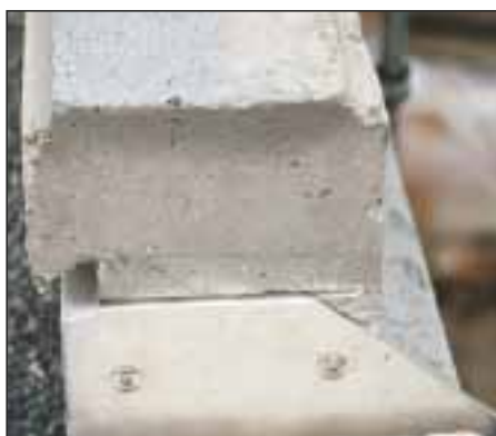
29. W miejscu, gdzie nie ma wgłębienia w balustradzie, nacina się w betonie rowek, do którego wsuwana jest górna krawędź blachy.
