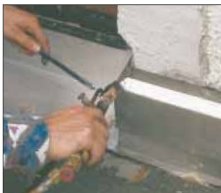
28. Po zanitowaniu poszczególnych odcinków blachy, miejsca styku i naroża są dodatkowo zalutowane, aby zapewnić idealną szczelność.
