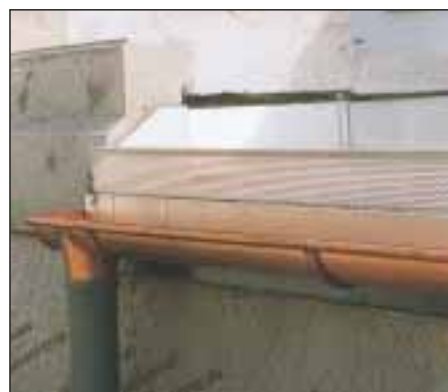
30. Tak wygląda wykończenie otwartej części tarasu: osłona rynny wykonana z perforowanej blachy, blacha narożna, rynna i odpływ.
