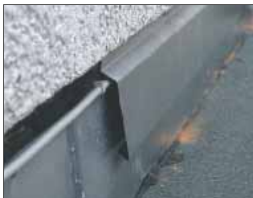
24. Po założeniu ostatniej warstwy czas na blachę osłonową, która w górnej i dolnej części jest wyprofilowana i umożliwi swobodne spływanie wody.
