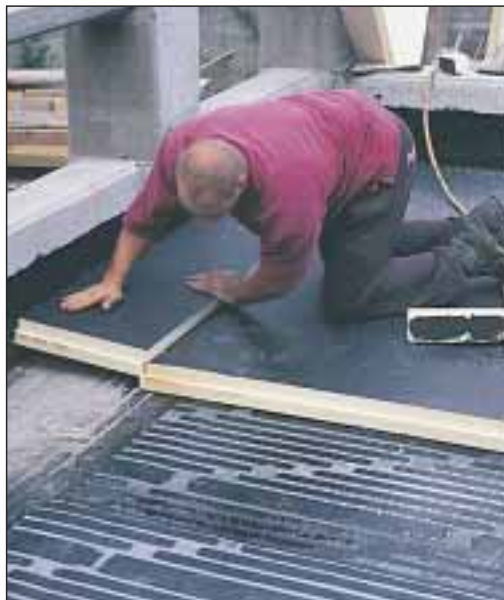
5. Przycinając poszczególne elementy płyt należy zwrócić uwagę, aby połączenia były szczelne. Wymagana jest więc duża precyzja.
