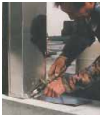
20. Teraz można przylutować obramowanie słupka do blachy po stronie wewnętrznej cokołu.
