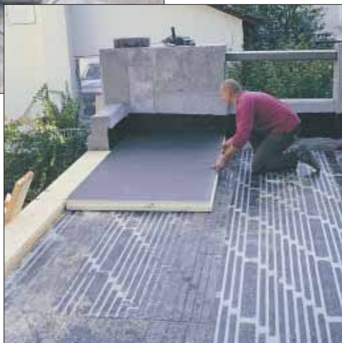
4. Zaraz potem nakłada się płyty izolacyjne i dociska do podłoża. W ten sposób powstaje trwałe złącze. Drewniane obramowanie z desek musi mieć tę samą grubość co płyty.
