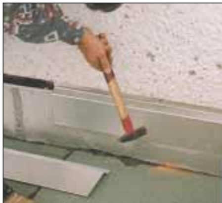
25. Po przewierceniu blachy osłonowej w miejscu zagięcia przybija się ją do muru. Po precyzyjnym przycięciu ...
