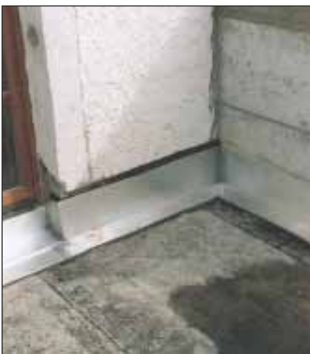
17. Obróbce blacharskiej poddano także ścianę budynku. Kątowniki z blachy położono na pierwszej warstwie uszczelnienia.
