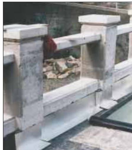
15. Po założeniu wszystkich płyt na słupki, kontynuują się prace związane z podłożem. Widać już luźno ułożone blachy.
