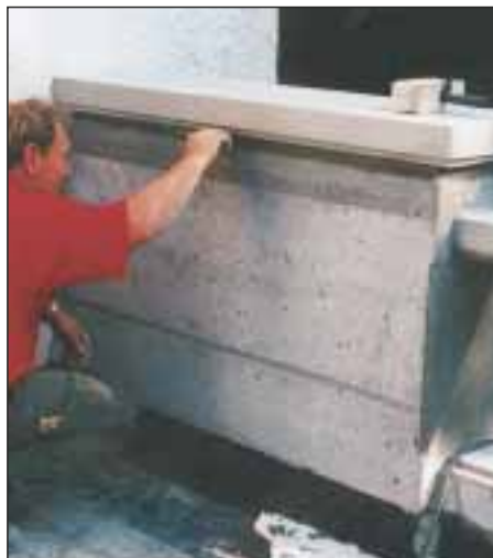
14. Zaraz potem wykonuje się kielnią do spoin rowek o głębokości około 1 cm i równomiernie gładzi powstałą spoinę.
